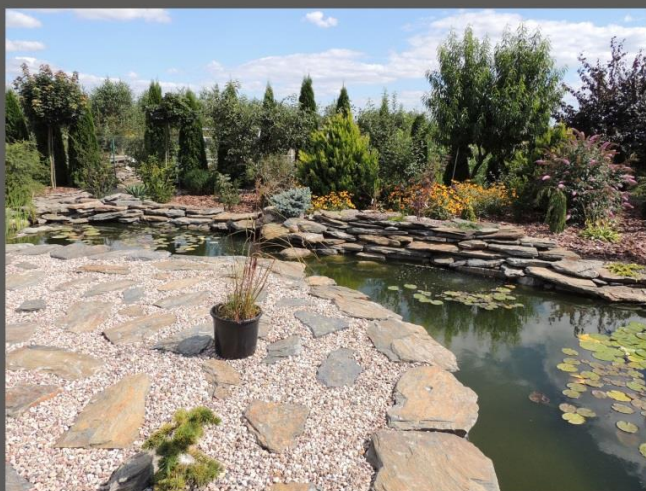
fot.1 Brzegi stawu umocnione łupkiem szarogłazowym
