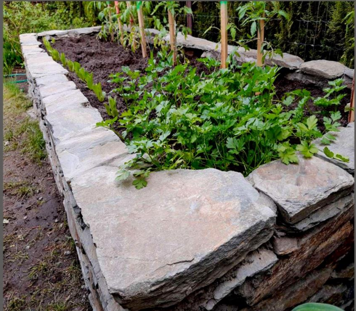
fot. 4 Wykończenie górnej warstwy
