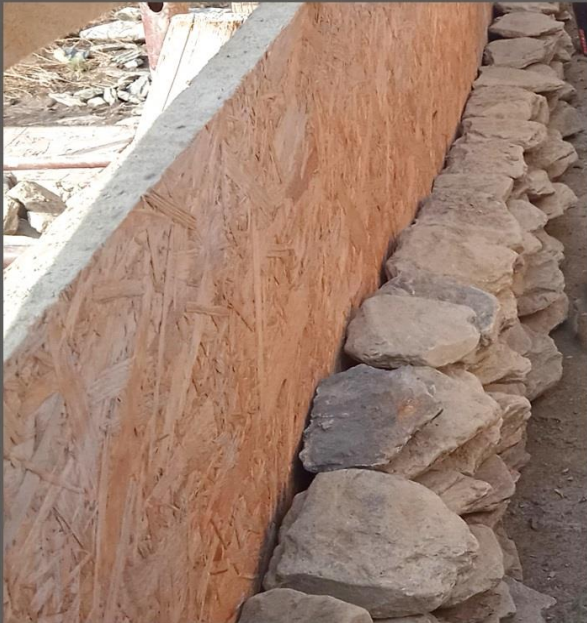
fot.3 Układanie murka przy pionowej płycie
