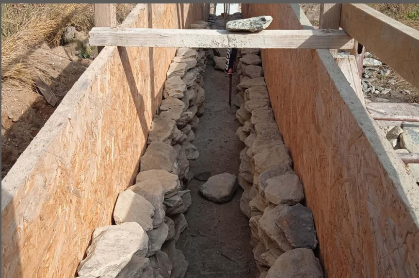
fot. 5 Budowa muru o grubości 50 cm z łupka szarogłazowego
